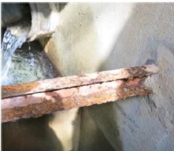
Détail des équipements - corrosion avancée
