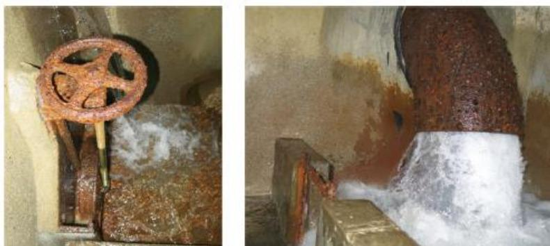
Détail des équipements - corrosion avancée
