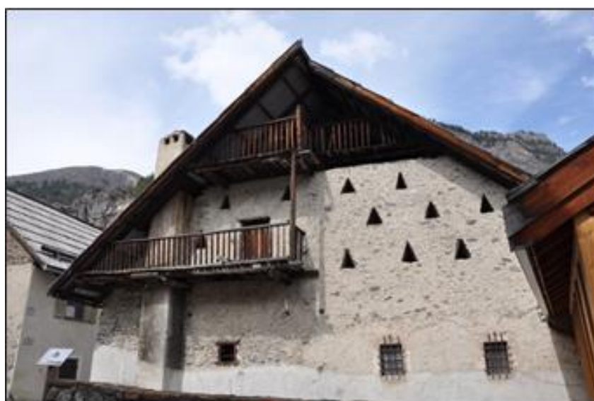
Construction traditionnelle au hameau de Ville Haute
