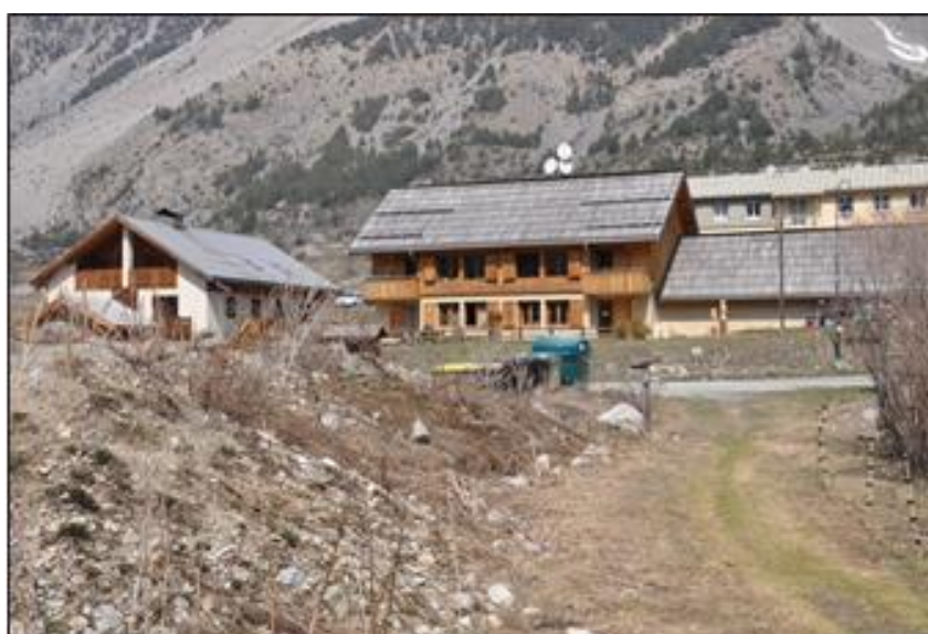
Constructions contemporaines en bordure de RN 994g - Le Cros - Sallé
