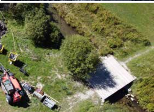
Fin août - Les fouilles pour les fondations de la gare de départ font office de piscine, qu'il aura fallu pomper ardemment avant de pouvoir couler le massif béton à l'aide d'un hélicoptère, le pont de la Lame ne supportant pas le poids d'une toupie béton. Tout est ensuite remblayé en régie accueillir le futur chalet.
