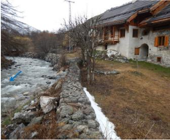
→ Renforcement de ce tronçon pour aboutir à un niveau de protection homogène de l'ensemble de la digue
