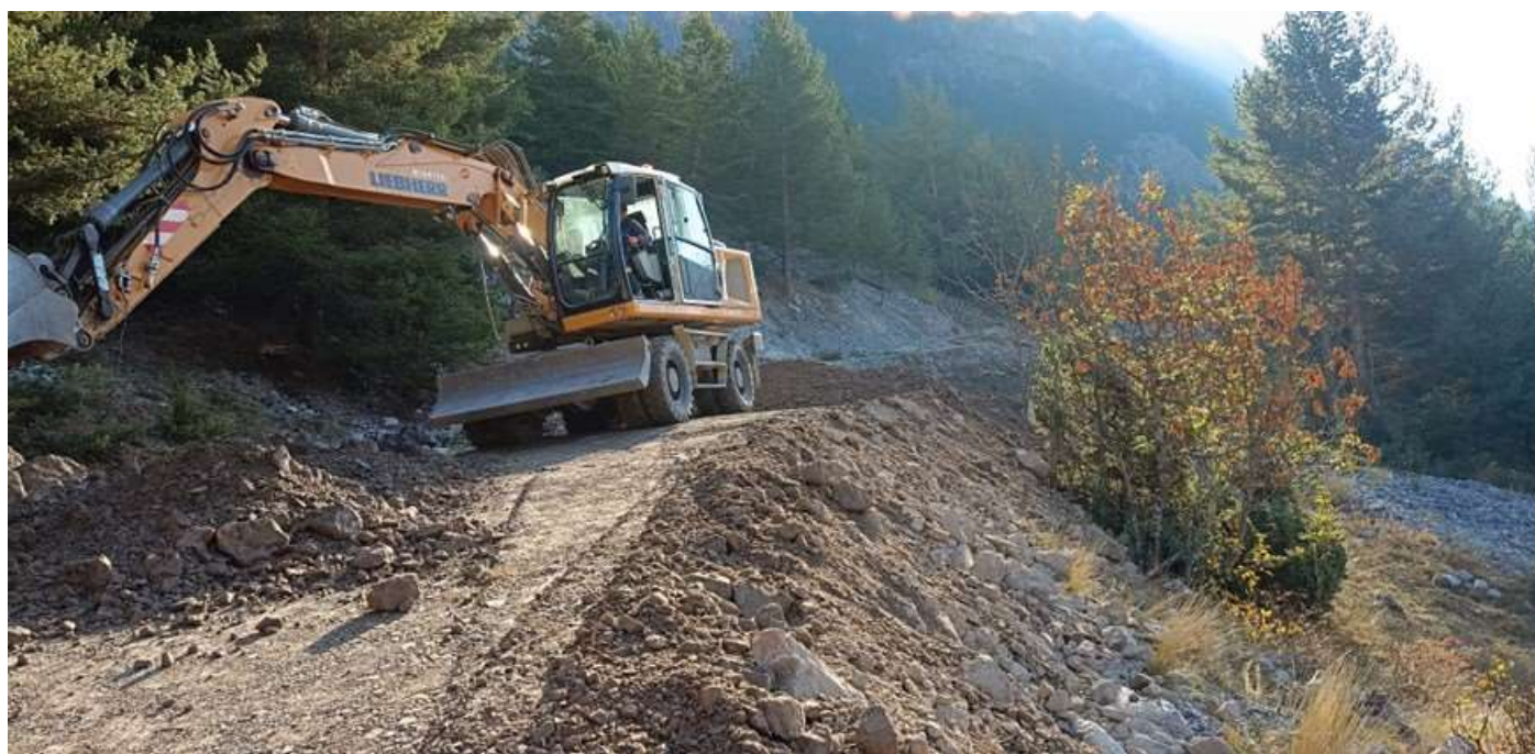
Fig. 2 : Route des Acles, vue vers l'amont, terrassements en cours.
