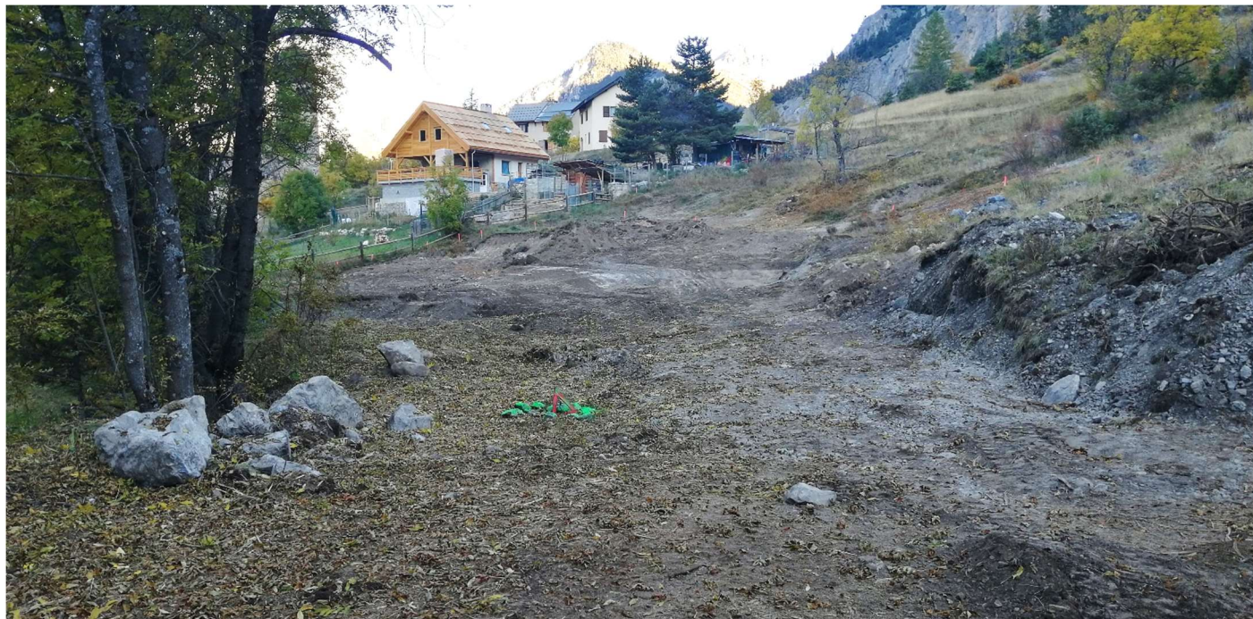
Fig. 3 : Secteur « merlon-fosse » ; décapage de la couche superficielle (13/10/25).
