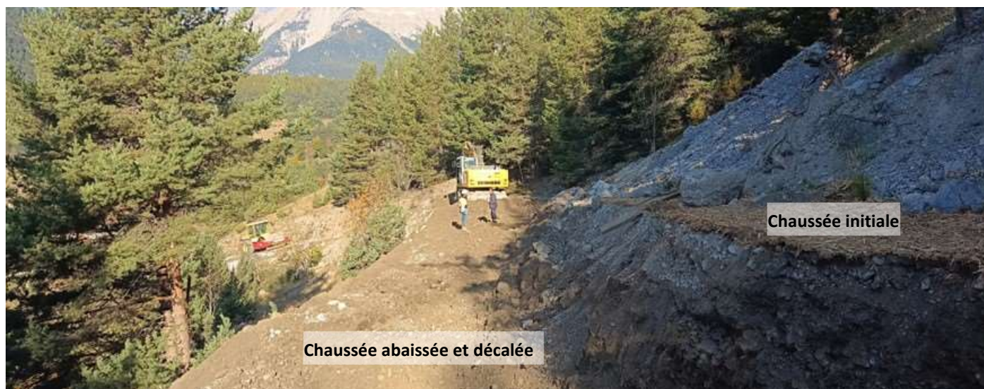
Fig. 1 : Route des Acles, terrassements au niveau du point bas du projet
