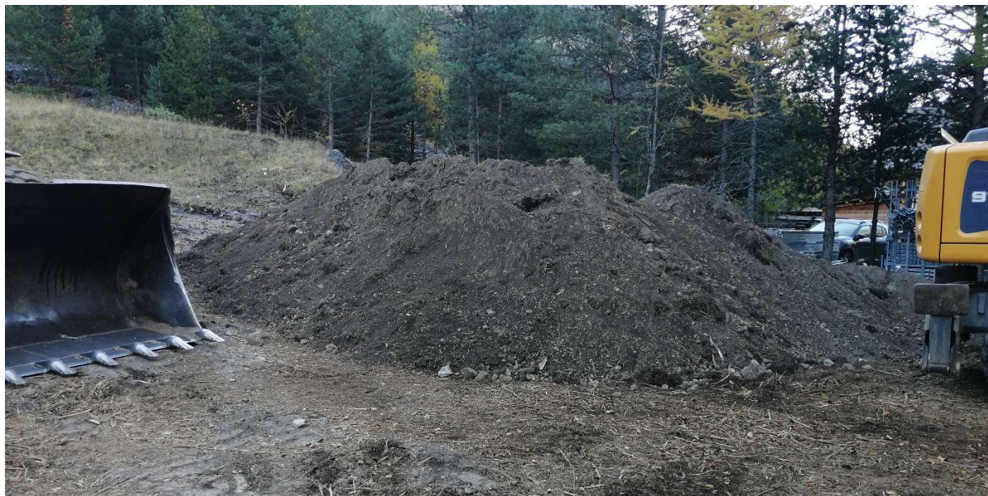
Fig. 4 : Secteur « merlon-fosse » ; stockage provisoire de la terre végétale (13/10/25).
