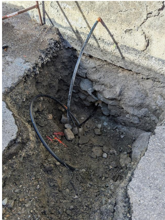
Figure 3 : Branchement renouvelé et passage de mur du n°110 Rue du pied de ville
