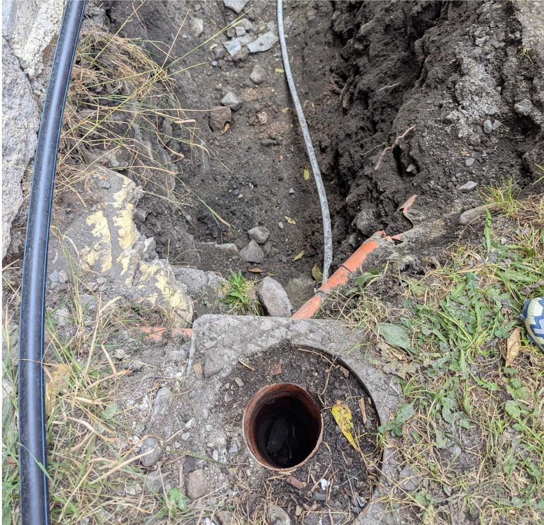
Branchement 8 : 10 Impasse des Antonins : le branchement de la brasserie est un matériau étranger. Par conséquent, nous n'avons pas de raccord pour ce matériau-là. Une vanne a été localisée au droit de l'entrée de la maison. Il a été convenu de creuser jusqu'à cette dernière pour y raccorder le plymouth neuf. Il restera la mise en place du Paragel.
