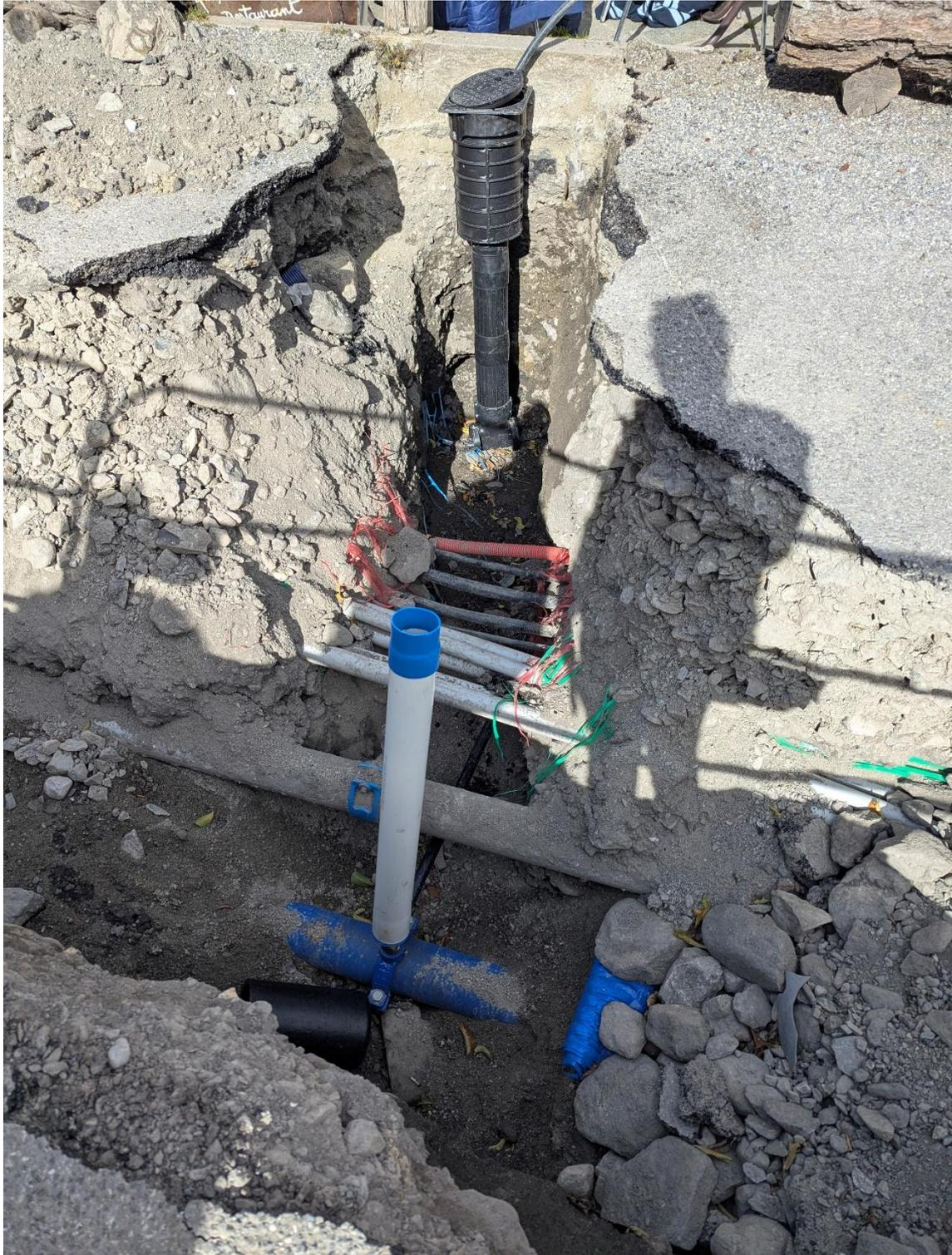
Branchement 14 renouvelé avec mise en place d'un paragel simple : 22 La Place Le Vialaou.
