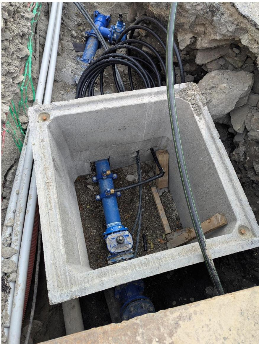
Regard Place de l'Eglise : mise en place d'une vanne de sectionnement (la conduite sera renouvelée jusqu'à cette vanne pour l'automne 2025), de deux piquages (un pour [REDACTED] et un second en attente).
