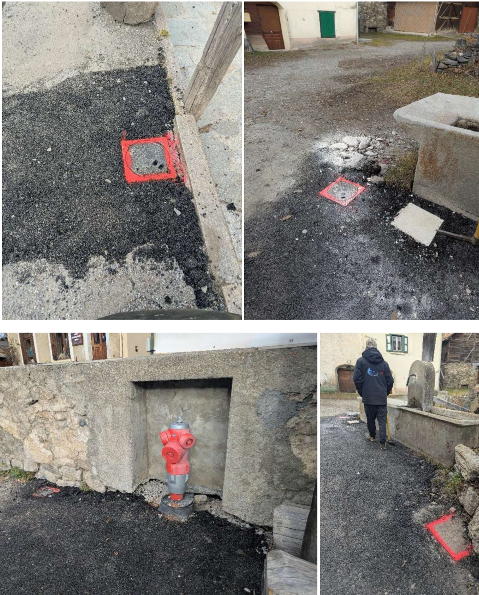
Figure 1 : enrobés à froid provisoire
