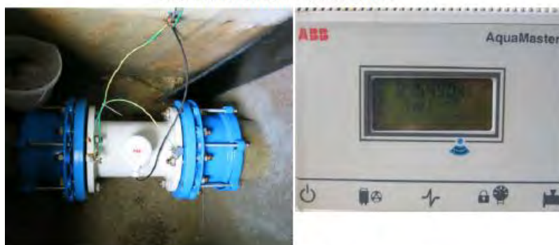
Détail du débitmètre au départ de la conduite (DN200)
