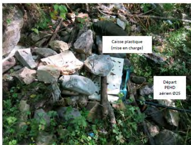
Vue intérieure de la chambre de captage septembre 2016 (le captage a été repris depuis)
