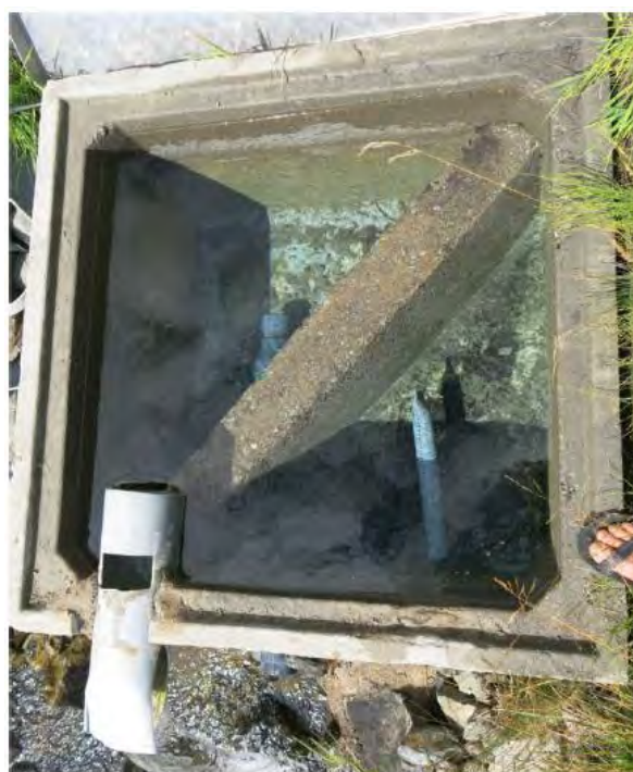
Vue intérieure du regard de captage
