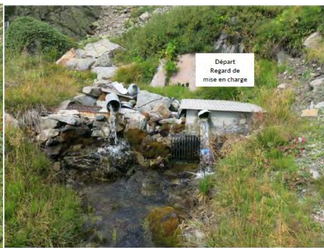
Vue extérieure de l'ouvrage de captage
