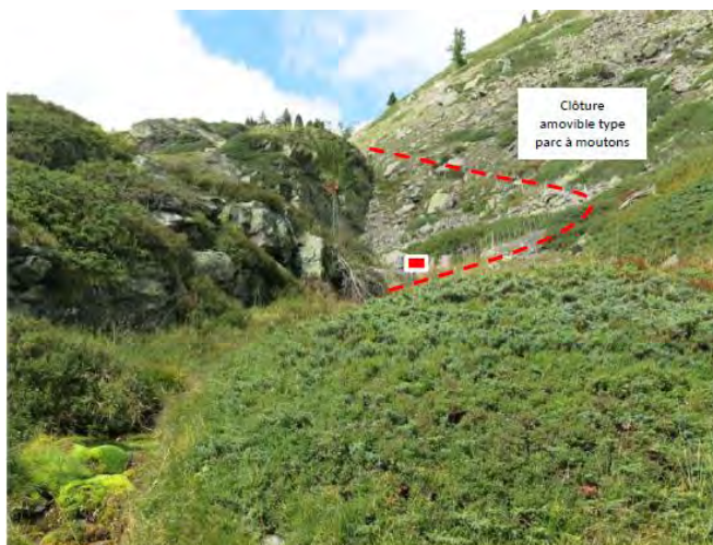
Vue d'ensemble de l'ouvrage en septembre 2018
