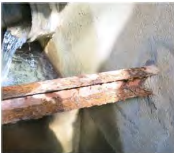
Détail des équipements - corrosion avancée (poutrelle IPN inutilisée)
