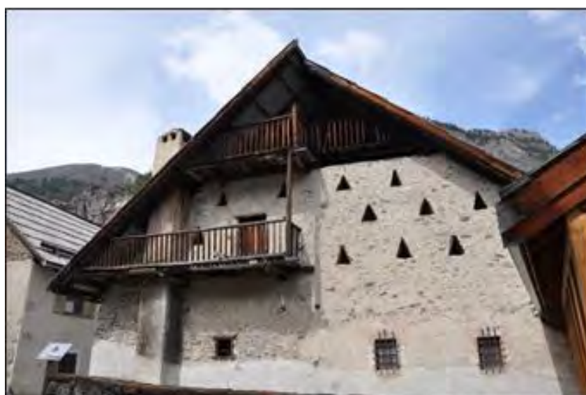
Construction traditionnelle au hameau de Ville Haute
