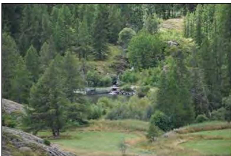
Haute vallée de la Clarée, la microcentrale électrique de Debaret
